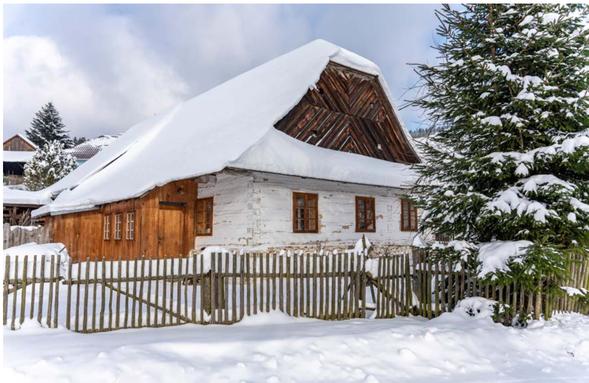
Javorek, chalupa čp. 23 je typickou ukázkou horácké lidové architektury.
